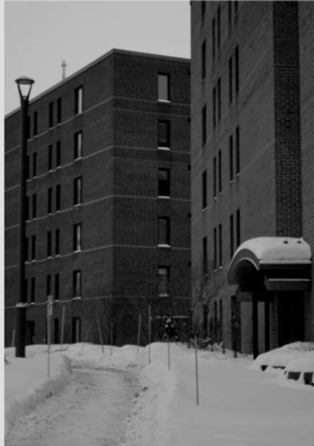
RUE SAINT-LAURENT - LÉVIS
